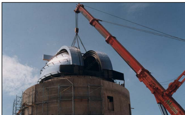
Figura 1b: Posa della cupola sul cilindro.
